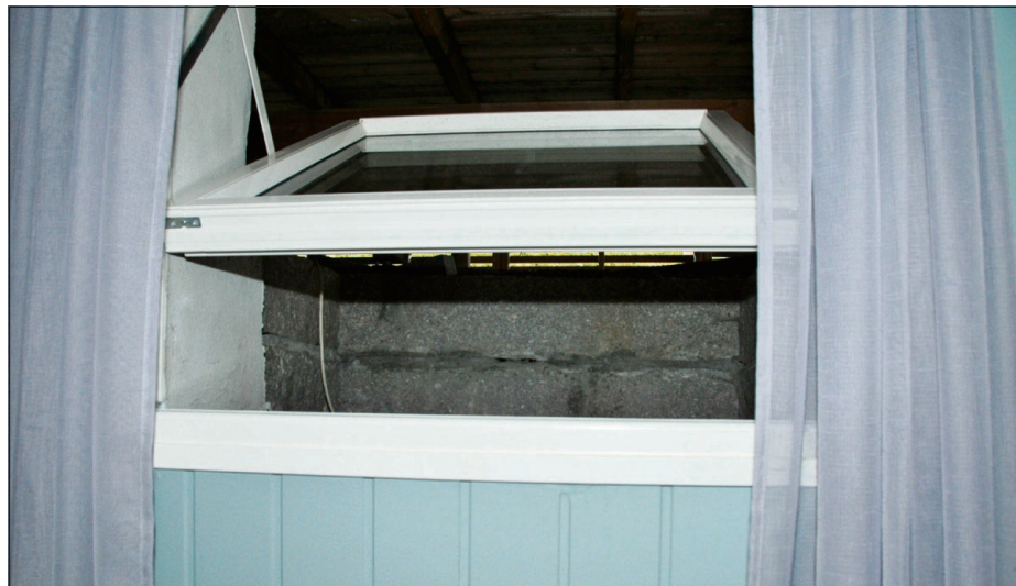
IKKE GODKJENT: Det viste seg at vinduet i soverommet i kjelleren ikke var godkjent i forhold til rømningsvei.
