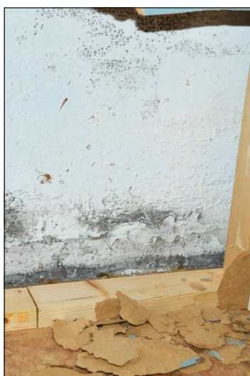
FUKT: Da Pelias måtte rive vegger i kjelleren på grunn av rotteproblematikken, fant de mugg og sopp som var skjult bak veggene.
